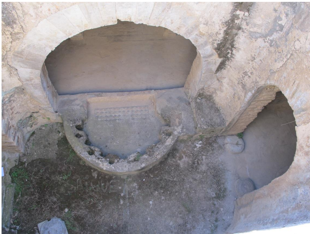
Fig. 3: Bulla Regia. "Casa de la pesca". Piso subterráneo. Peristilo. (Foto de autor 2017).
